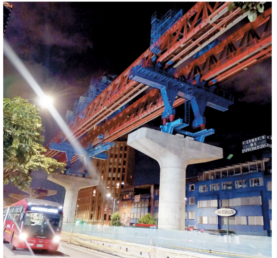
Se denuncian retrasos en las obras del Metro. Foto ZHB.
